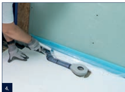
4. Na úroveň instalace uložit izolaci kročejového hluku.
