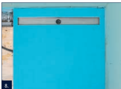
8. Seříznout všechny vrstvy skladby s hranou sprchové desky, aby bylo možné následné navázání podlahové konstrukce.
