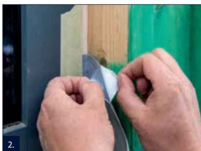
2. Při nedostatku místa lze vytvořit napojení do 15 cm nad úroveň terénu pomocí butylové pásky BD. Butylovou pásku následně celoplošně překrýt hmotou RD 2.
