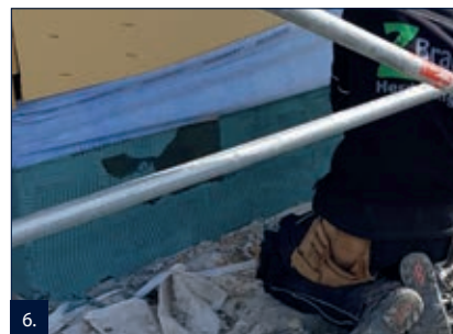
6. Hmotu RD 2 celoplošně nanést na proschlou uzavírací vrstvu pomocí zubové stěrky.
