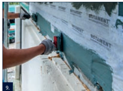
9. Uložit izolační pásku PB do čerstvého vrstvy RD 2 bez zvrásnění a svědomitě překrýt okrajové části hmotou RD 2.
