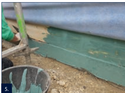
5. Předem navlhčit betonové plochy. Uzavírací vrstvu provést na betonovém i dřevěném podkladu. Stáhnout přebytečný materiál.
