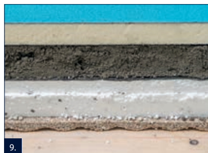
9. Konstrukce podlahy s optimální zvukovou izolací a maximálním komfortem pochůziho sprchového koutu v úrovni podlahy.
