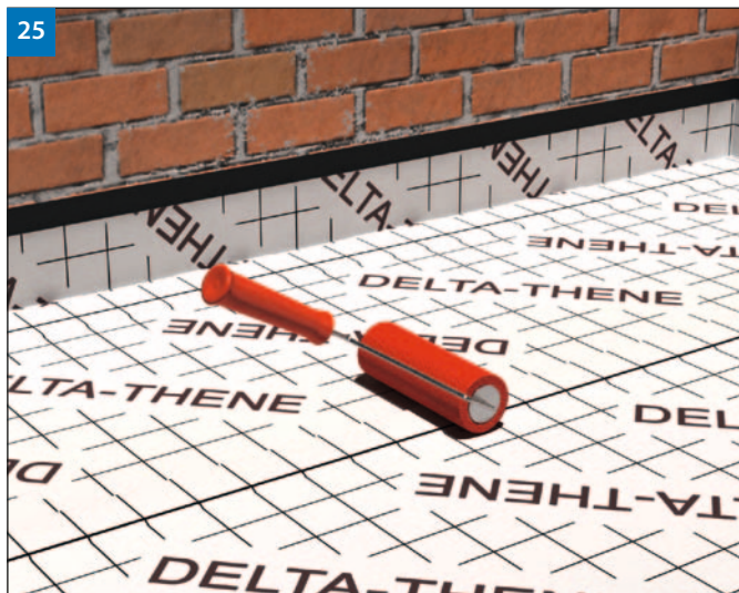
(obr. 25). Všechny přesahy se důkladně přitlačí pomocí válečku.
